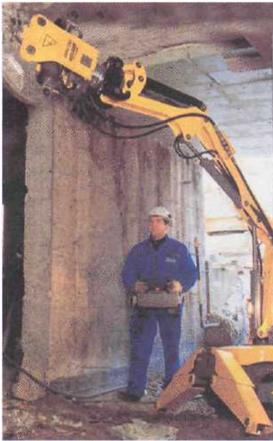
Slika 1. Minijturni roboti za rušenje BROKK 330 sa škarama CC 560
