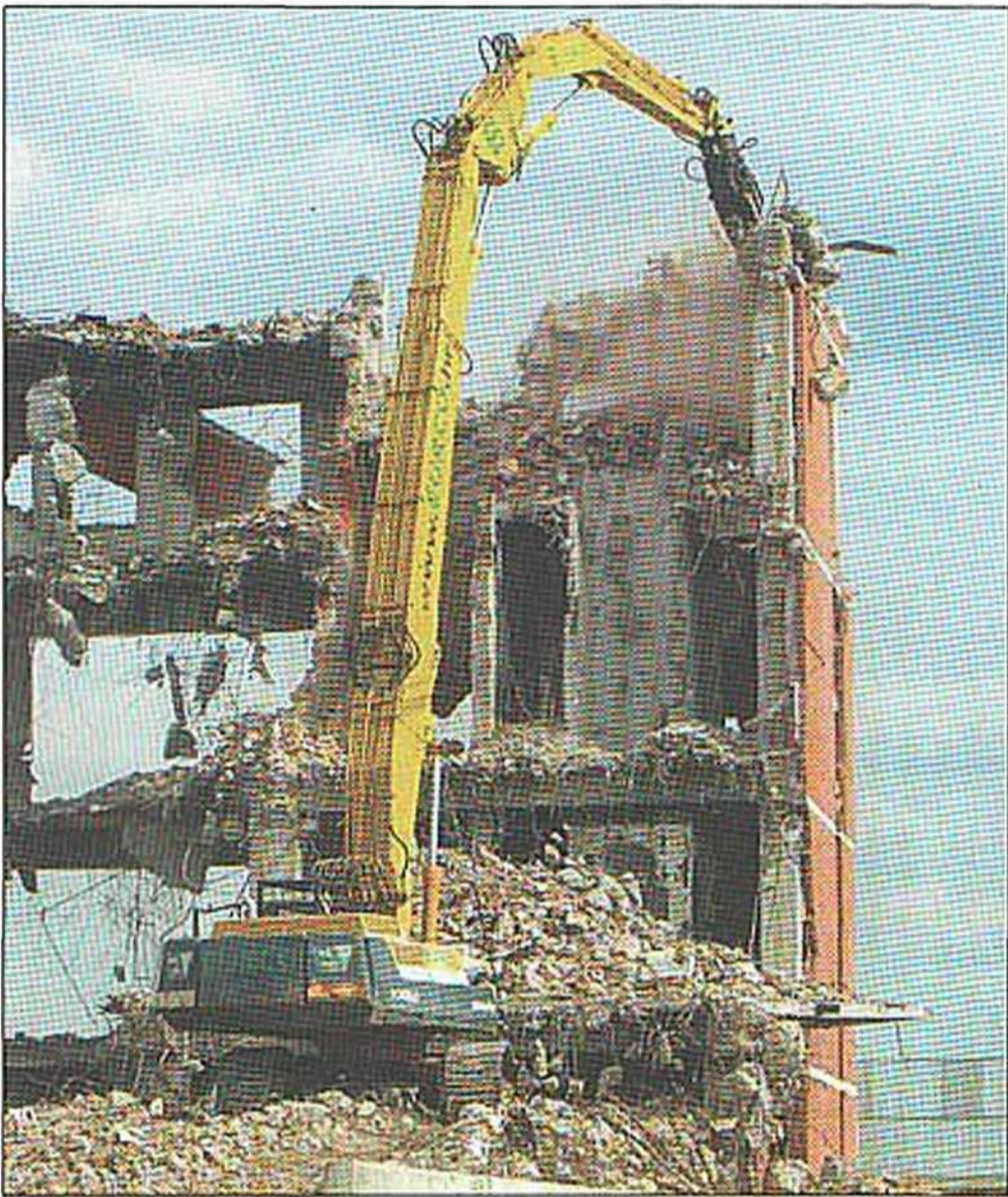
● Primjena građevinskog stroja u rušenju objekata
