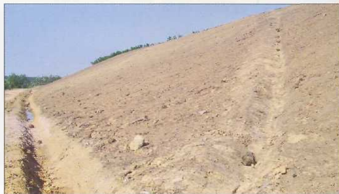
● Uređenje kanala za odvodnju oborinske vode
