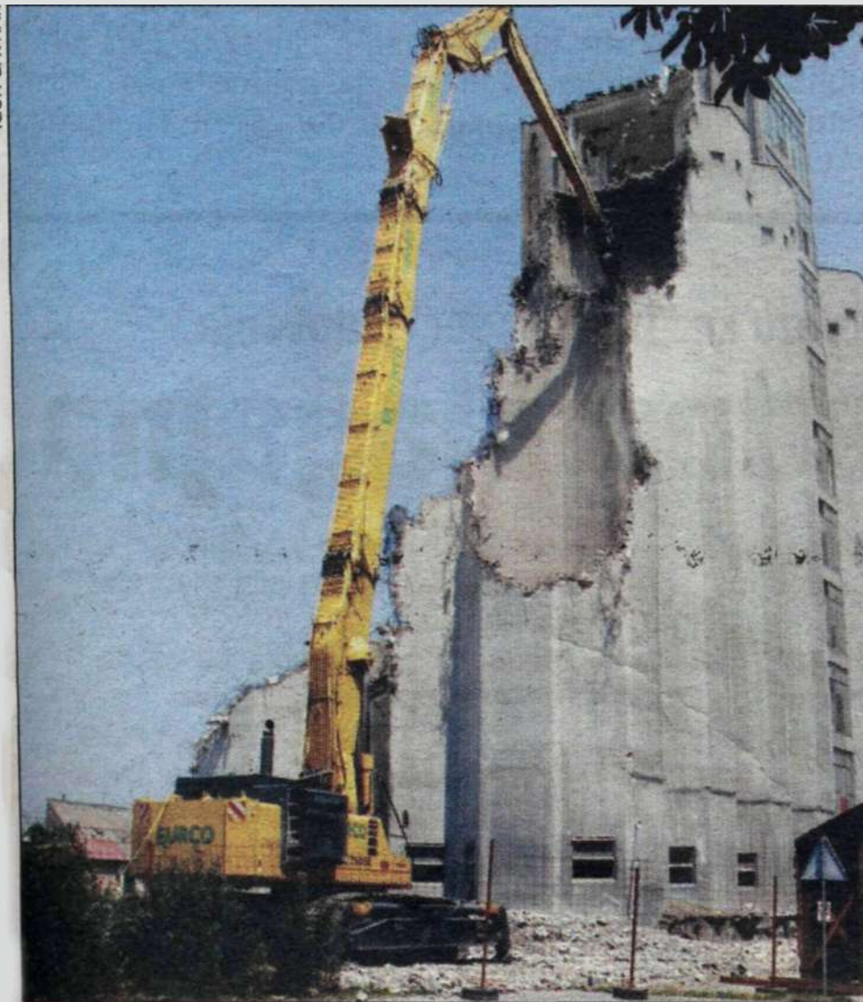
Hidraulični bager dohvata od čak 40 metara ruši silos
