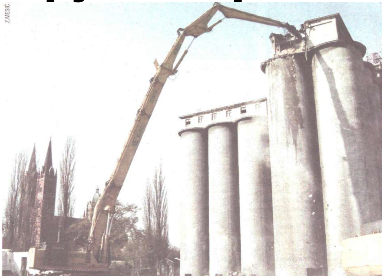
Strojevi Eurcoa na djelu - rušenje silosa u Đakovu snimljeno u ožujku ove godine
